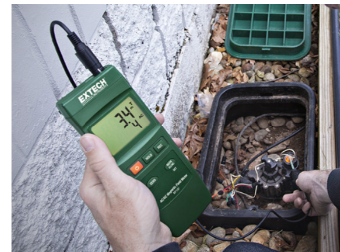
Het meten van de AC-magnetische velduitgang van het sprinkler-relaissysteem
